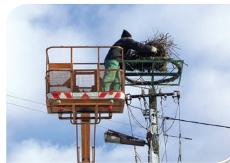
Wkładanie wyściółki na platformę metalową zainstalowaną na słupie energetycznym. Fot. AT
