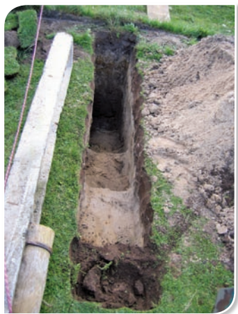
Schodkowy wykop ułatwiający ustawienie słupa. Fot. AT
