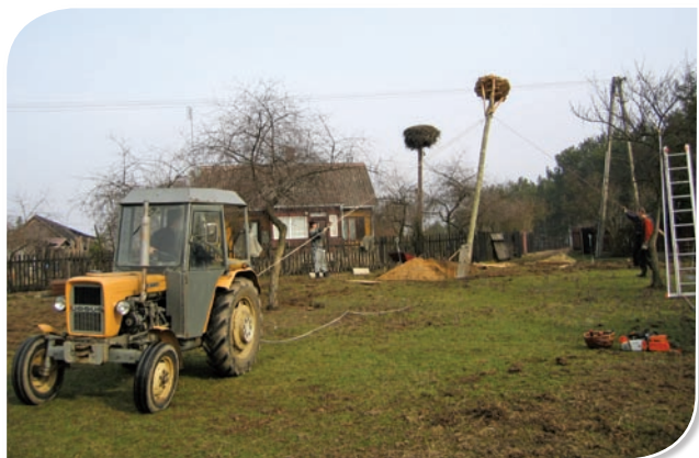
Ustawianie słupa przy pomocy traktora. Fot. AT
