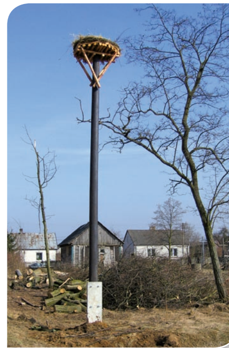
Słup drewniany na szrudle betonowym wraz z platformą. Fot. AT
