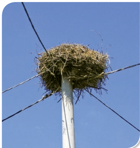
Gniazdo na linii energetycznej zmodernizowanej (przewody w czarnej izolacji są splecione w warkocz). Fot. AT
