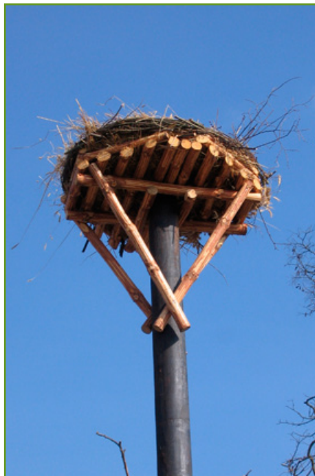
Sposób montażu platformy gniazdowej uniwersalnej na słupie drewnianym. Fot. AT
