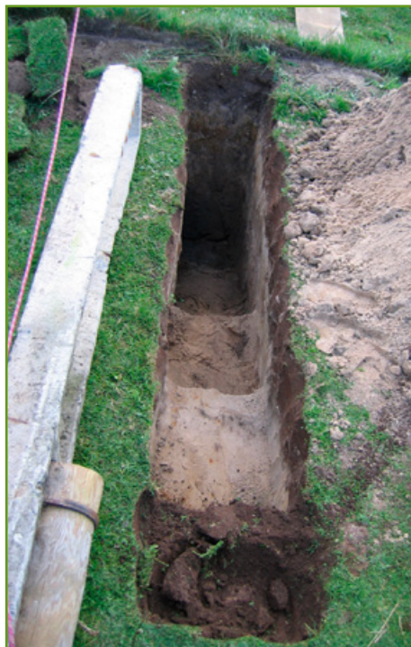
Schodkowy wykop ułatwiający ustawienie słupa. Fot. AT
