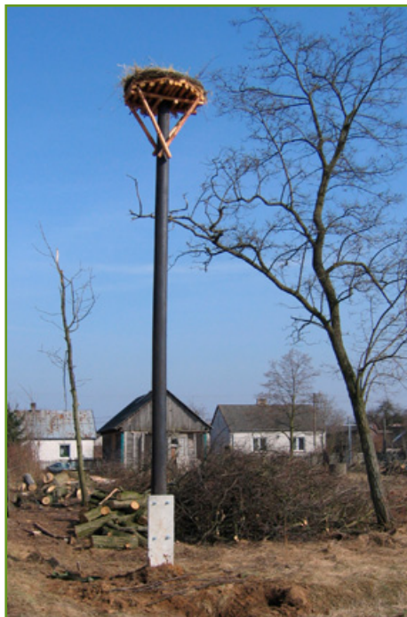
Słup drewniany na szczudle betonowym wraz z platformą. Fot. AT
