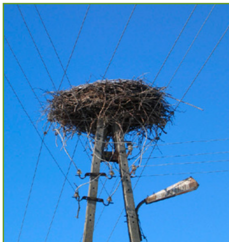
Gniazdo na linii elektroenergetycznej z przewodami „gołymi”. Fot. AT
